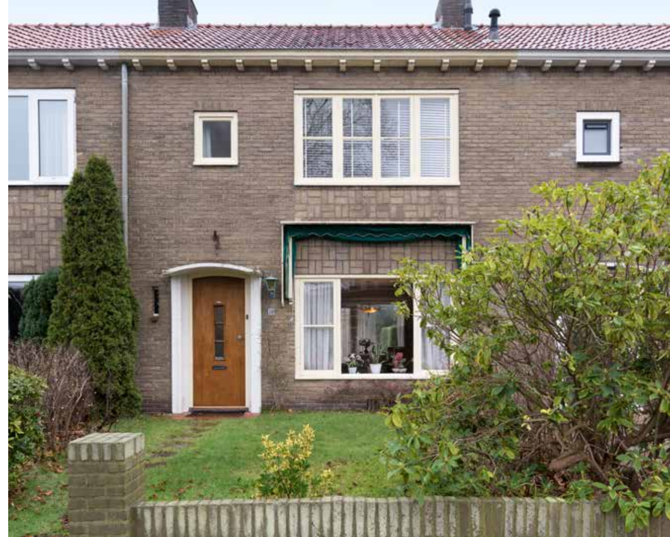
Sinds de bouw in 1954 is er weinig veranderd aan het exterieur van de woning aan de J.P. Coenstraat 80 in Hilversum
