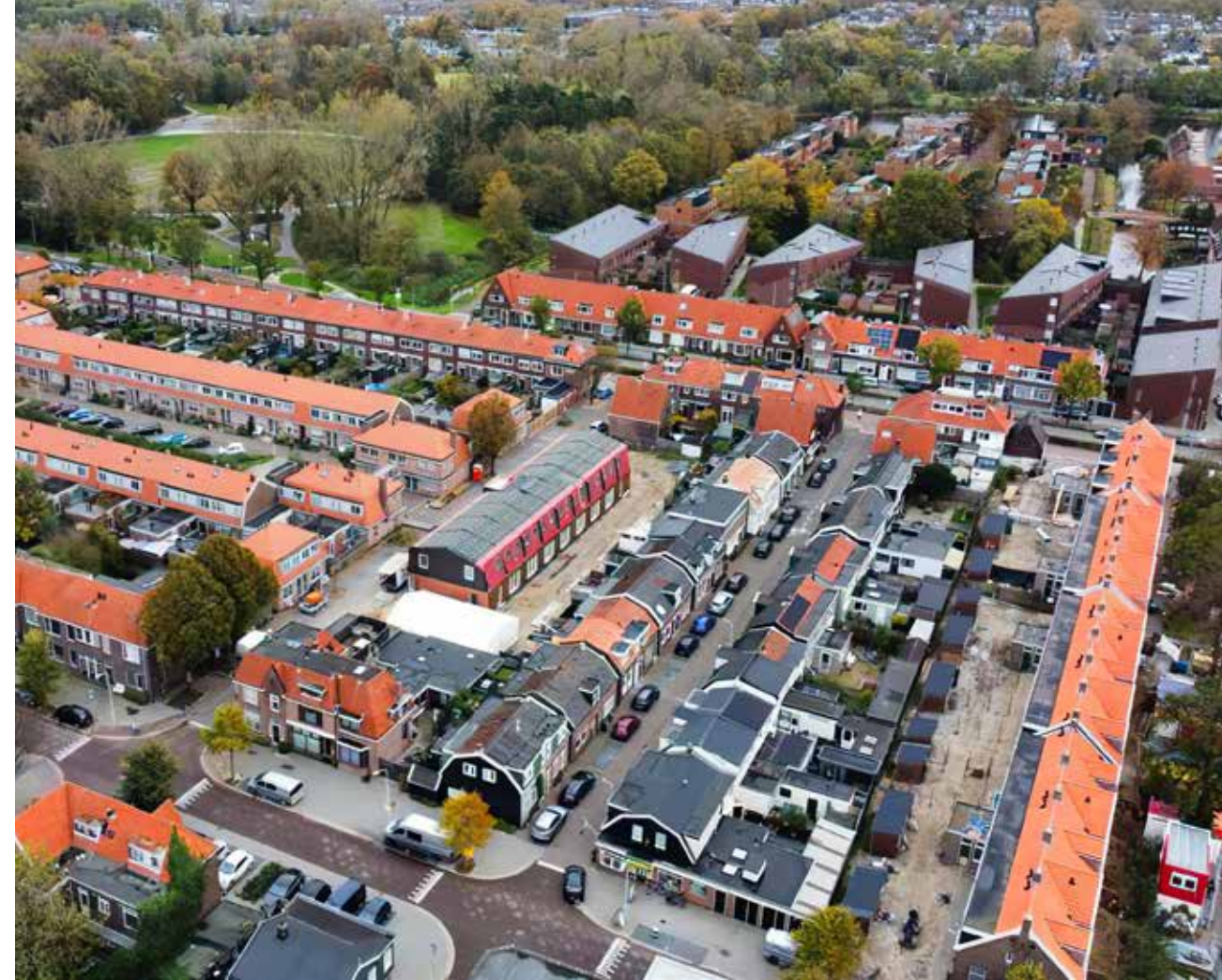
Het eerste modulaire woningblok na plaatsing in de wijk
