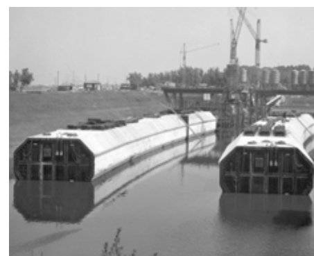
In de jaren zestig van de vorige eeuw werden in het voormalige bouwdoek de caissons voor de Rotterdamse metro gemaakt
