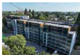
1 Woningstichting Eigen Haard Aquarius AG NOVA Architecten
