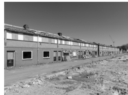
Woningen Brugmanstraat net voor de sloop
